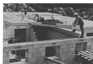
*Ytong*, une contribution à l'économie d'énergie, éprouvé depuis plus de 50 ans. Le matériau de construction idéal pour toutes les zones climatiques. *Ytong* est un béton cellulaire durci à l'autoclave, fabriqué à partir d'un matériau de base siliceux (sable), du ciment, de la chaux et d'un agent gonflant (poudre d'aluminium). Maçonnerie *Ytong* = isolation thermique élevée. Valeur K 0,37 Kcal/h m² °C.
