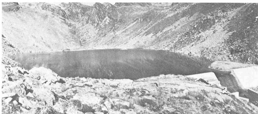
Irrigation aujourd'hui : le bassin de Louvie (val de Bagnes). Altitude : 2210 m ; capacité : 150 000 m³. Louvie-La Chaux : galerie de 3700 m ; La Chaux - Pierre-Avoi : acqeduc de 11 km ; galerie de la Pierre-Avoi : 700 m ; Pierre-Avoi - Pas-du-Lin : conduite de 3300 m.
