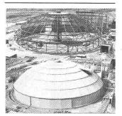
Ossature métallique des dépôts à matière première et clinker de la nouvelle cimen-terie de Yandev au Nigéria. Etat du chantier au début de 1979.
