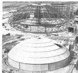
Ossature métallique des dépôts à matière première et clinker de la nouvelle cimenterie de Yandev au Nigéria.
