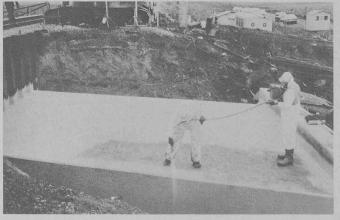
Application de la résine méthacrylate Degadur ® sur l'une des deux parties du nouveau pont en béton des Chemins de fer britanniques à Shippea Hill. L'opération s'est effectuée impeccablement et n'a causé aucune difficulté au personnel. On aperçoit, en haut et à gauche, les rails sur lesquels le trafic ferroviaire a continué à circuler en une seule voie sur l'autre moitié du pont.
