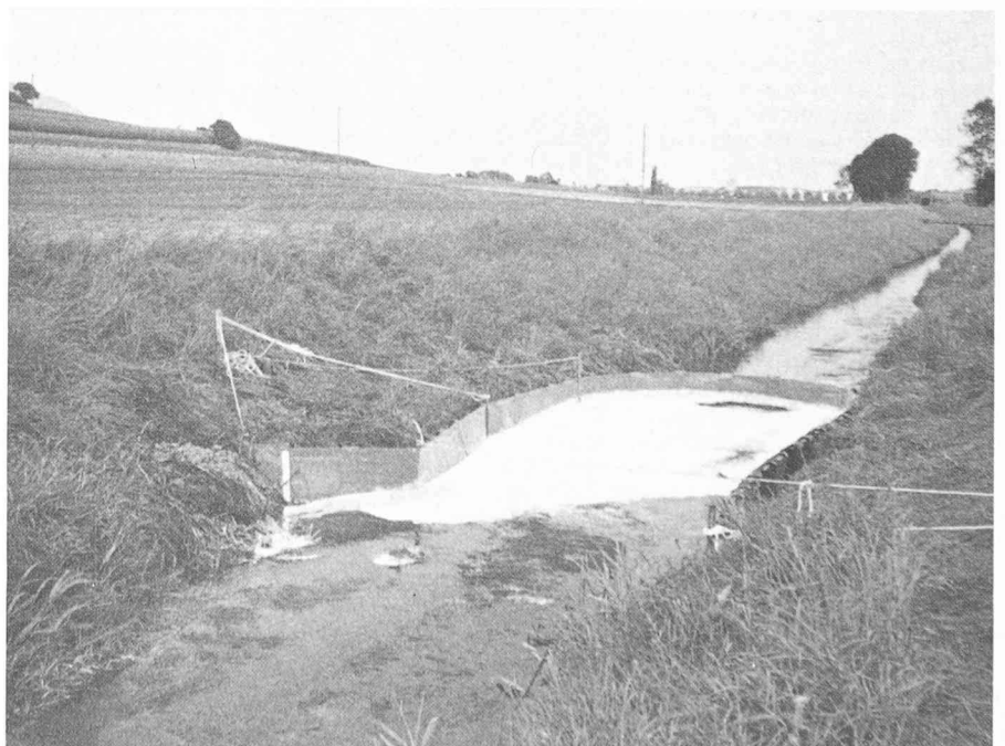
Fig. 5. — Barrage rapide posé au travers d'une petite rivière souillée d'hydrocarbures. Les produits absorbants sont arrêtés par le barrage.
