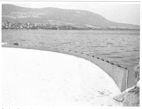
Fig. 6. — Il est parfois nécessaire de placer le barrage à l'embouchure d'une rivière dans un lac, lorsque le courant est trop important pour stopper la pollution en amont.
