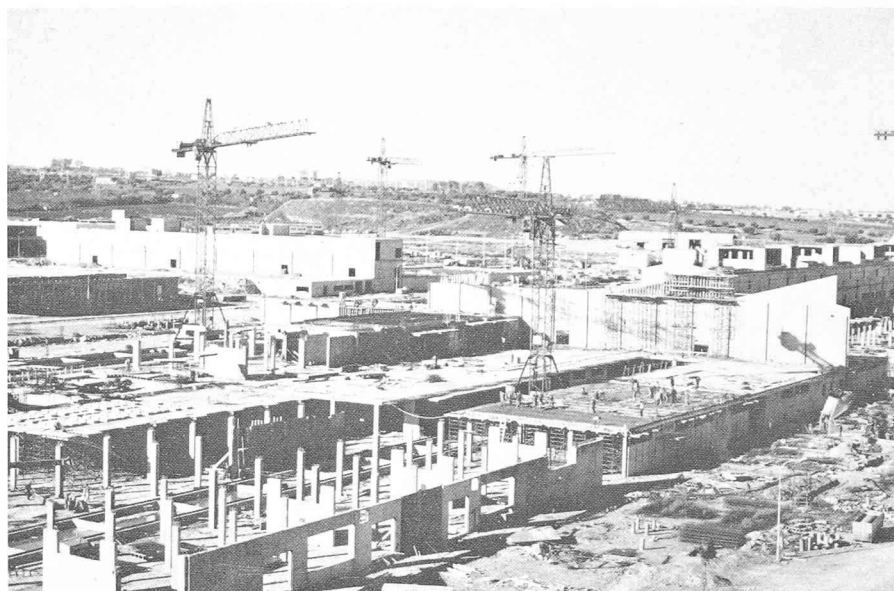
Fig. 2. — Complexe de soierie à Tlemcen (Algérie). Travaux de génie civil, de bâtiment et de constructions métalliques : surface bâtie 80 000 m 2 , volume des constructions : 750 000 m 3 . Exécution par l'association Zschokke-Dragados.
