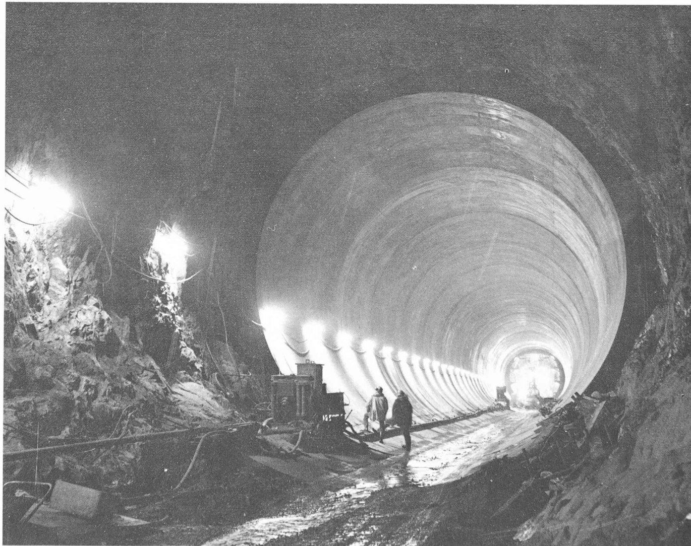
Fig. 1. — Galerie d'amenée (diamètre int. 10,50 m) de l'aménagement de pompage-turbinage à Dinorwic (Pays de Galles). Travaux de génie civil en souterrain : 1 250 000 m 3 d'excavation et mise en place de 500 000 m 3 de béton. Exécution par l'association Mc Alpine-Brand-Zschokke.
