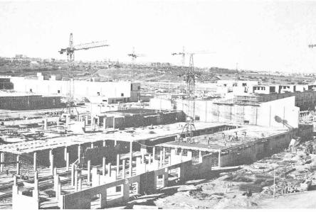
Fig. 2. — Complexe de soierie à Tlemcen (Algérie). Travaux de génie civil, de bâtiment et de constructions métalliques : surface bâtie 80 000 m², volume des constructions : 750 000 m³. Exécution par l'association Zschokke-Dragados.
