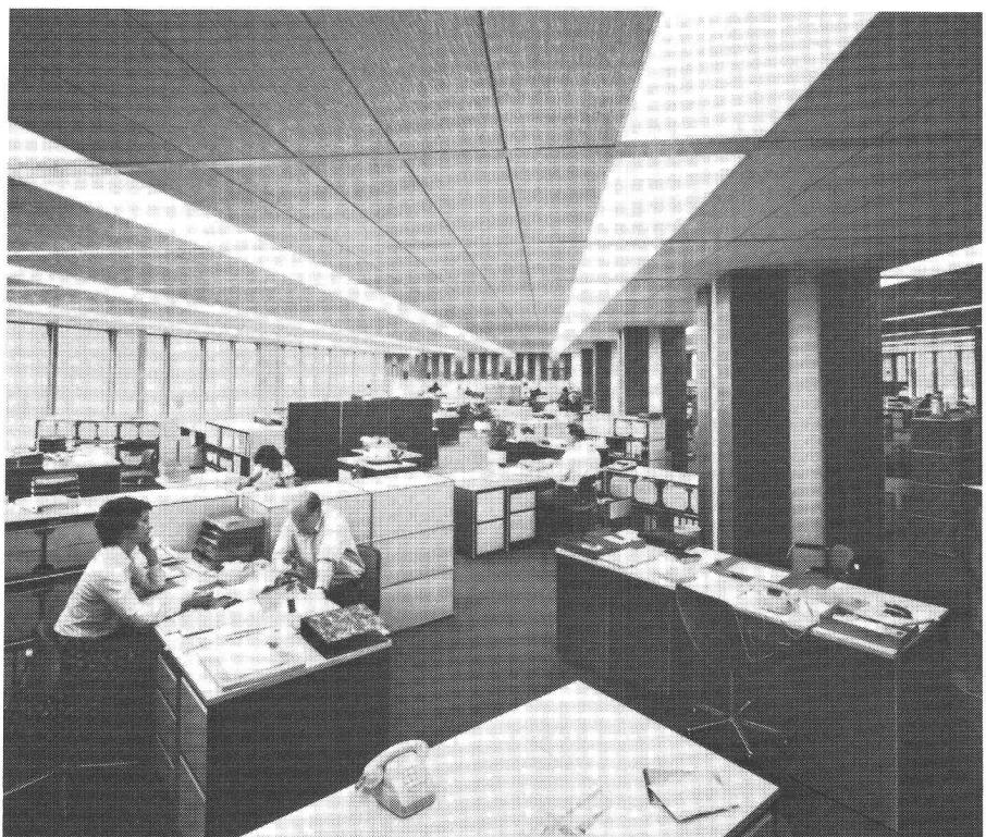
Avec les luminaires système SiLUZET. Le luminaire encastré à paralume à larges mailles est le modèle de base pour tous les luminaires à grand paralume et à climatisation intégrée. La conception modulaire du système permet de le compléter pour réaliser un luminaire à climatisation intégrée. Les luminaires SiLUZET à climatisation intégrée pour l'évacuation de l'air vicié dans une conduite sont constitués par le modèle de base surmonté d'une hotte d'aspiration reliée à la
