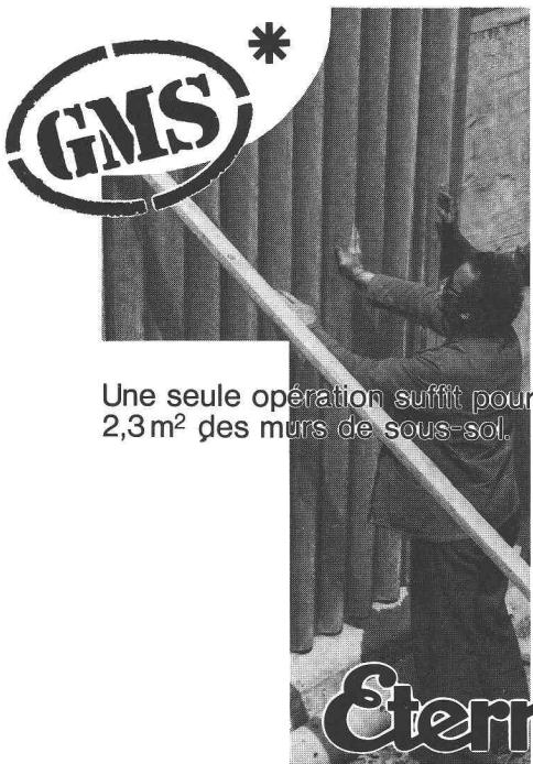
Une seule opération suffit pour couvrir 2,3m<sup>2</sup> des murs de sous-sol.
