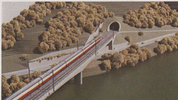
Fig. 11. — Modèle montrant le portail sud du tunnel du Born et le viaduc de Ruppoldingen.
