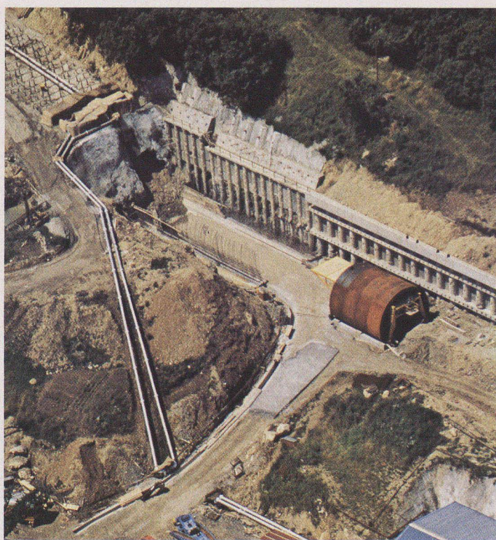
Fig. 10. — Vue aérienne de la zone du portail nord. De droite à gauche : tranchée précédant le tunnel ; coffrage métallique préparé pour le bétonnage de la voûte ; zone de congélation du terrain ; conduites de congélation.
