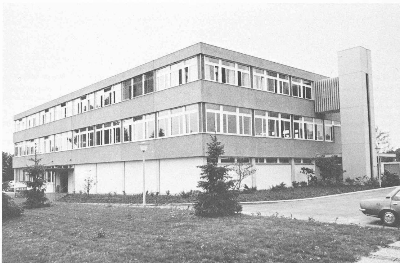
Le bâtiment de l'imprimerie vu de l'est.
