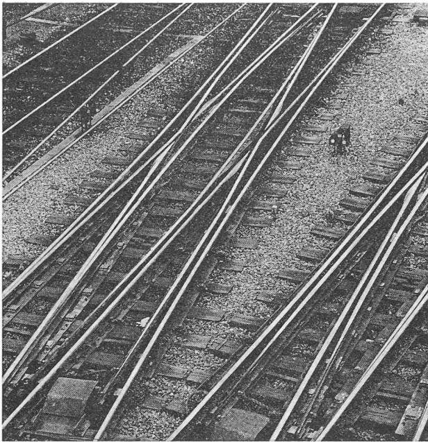
Fig. 117. — Appareils de voie.
