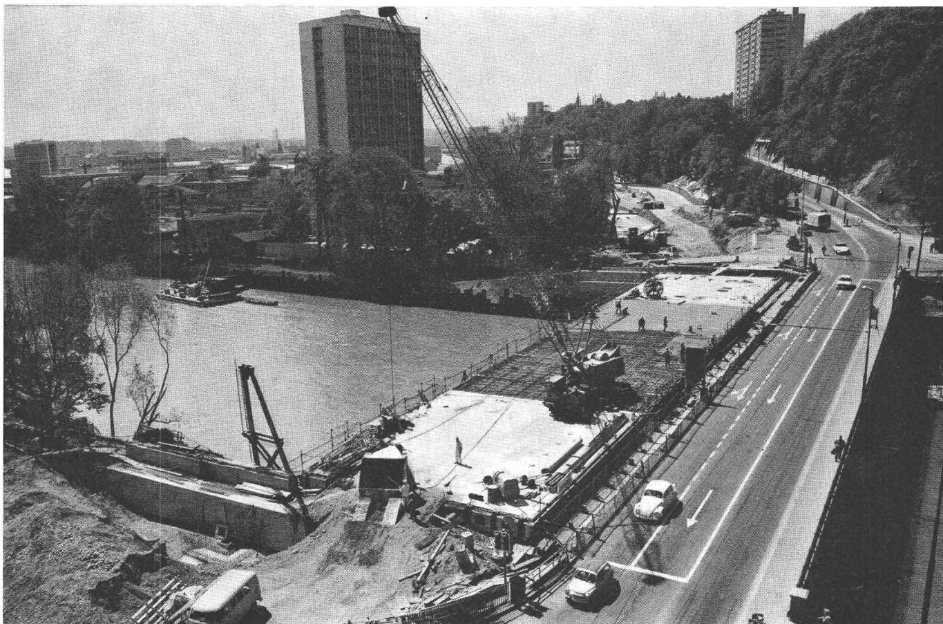
Pont de Saint-Georges sur l'Arve, Genève; Bétonnage du tablier sur éléments préfabriqués
