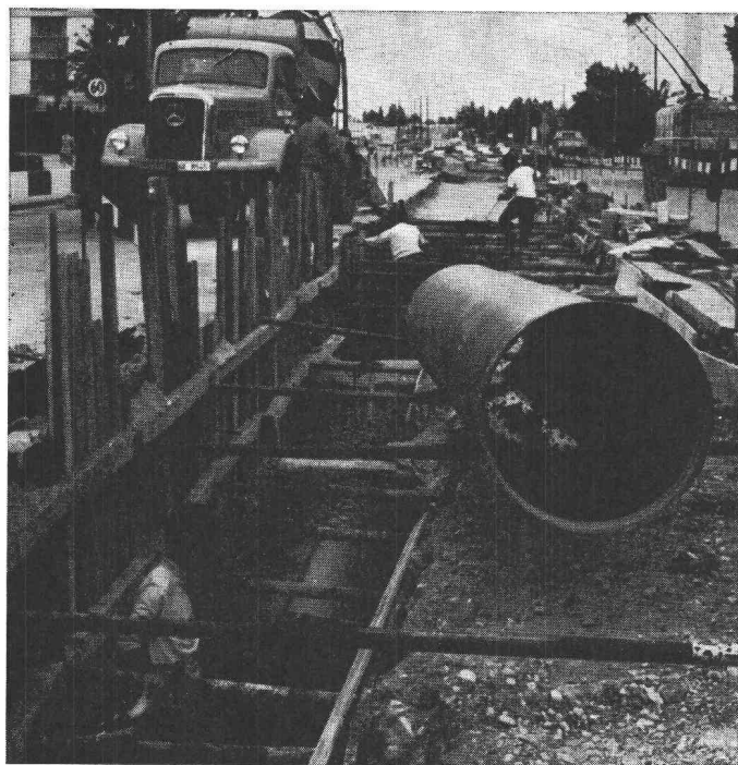
Collecteur d'eau usée à Onex GE \varnothing 70 cm
