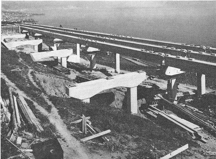
Fig. 4.— Montage du pont aval.
