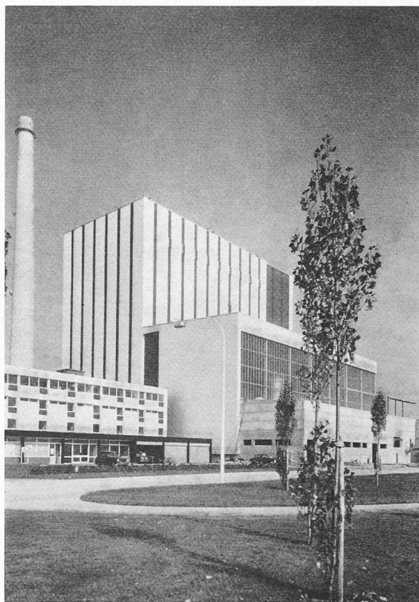
Fig. 2 — Centrale thermique de Blénod-Lès Pont-à-Mousson
