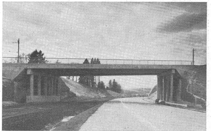
Pont du LEB et de la Roche PS RC 401
