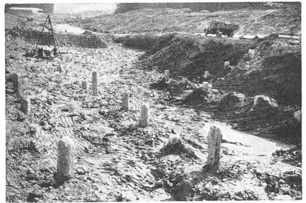
Fig. 7. — Forages dans les pieux.
