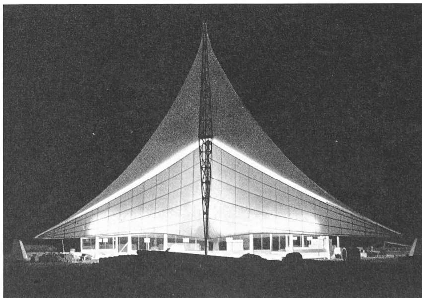
Fig. 41. — Élément du Secteur 1, « Partie générale ». C'est une structure en bois recouverte d'une toile plastique diffuse de 38 % de facteur de transparence. Dans ce cas, l'élément est éclairé de l'intérieur par un projecteur pour lampe à iode de 1000 W. Il est à remarquer les innombrables possibilités de jeux d'ombre et de lumière simplement par l'emplacement de la source lumineuse. Ces éléments de la « Partie générale » forment l'axe nord-sud de l'Exposition; de nuit, ils doivent ressortir du terrain comme des lanternes japonaises.
