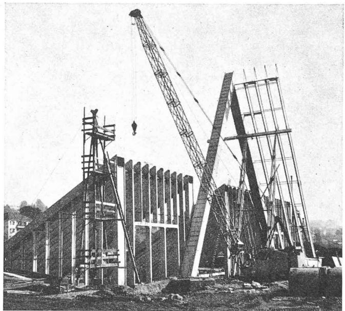
Fig. 18. — Etayage d'un élément de paroi.
