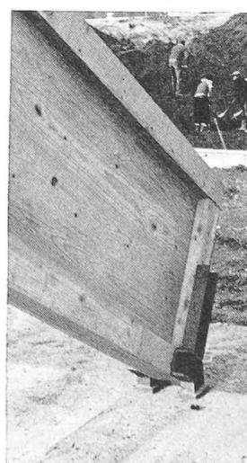
Fig. 14-15. — Le dispositif d'articulation au pied des poutres.
