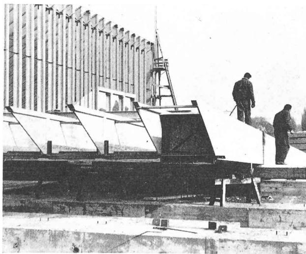
Fig. 13. — Diaphragme de raidissement d'une poutre caisson.
