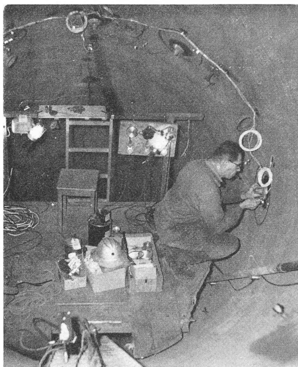
Fig. 5. — Mise en place des jauges de contrainte.
