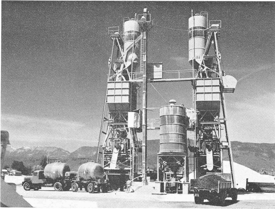
Fig. 13. — Centrale à béton.
