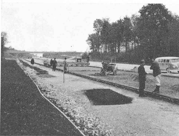
Fig. 14. — Mise en place de la couche de fin réglage.
