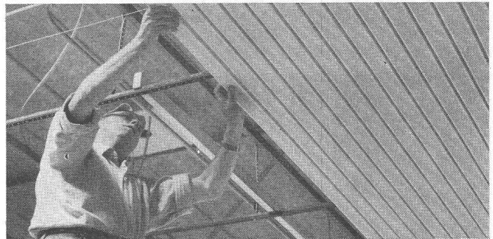
DAMPA lambris métalliques pour plafonds démontables. Pour l'acoustique et la ventilation
