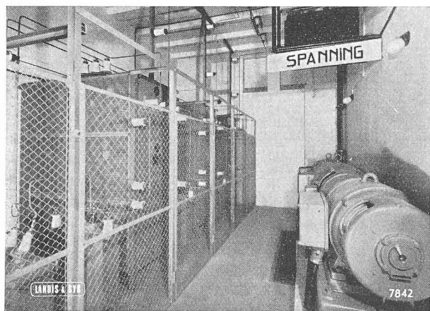
Fig. 16. — Groupe convertisseur de l'installation de télécommande des GEB Dordrecht (Hollande) avec ses 400 doubles-commandes. (Portées plus tard à 600.)
