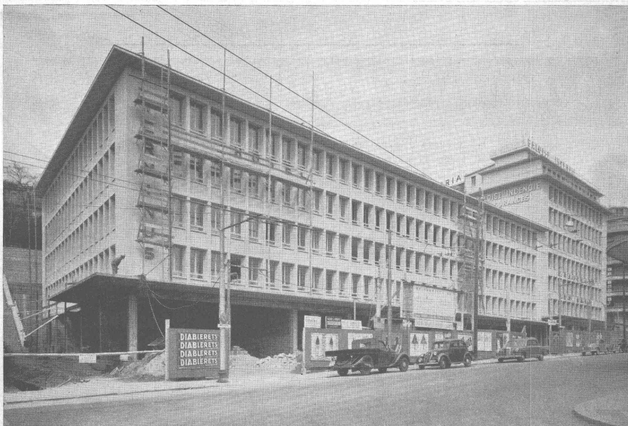
Bâtiment en cours d'achèvement, de l'hôtel Terminus à Lausanne. Oeuvre de l'architecte Ch.-F. Thévenaz. Les fenêtres sortent des ateliers de la Fabrique Coopérative de Menuiserie à Renens.
