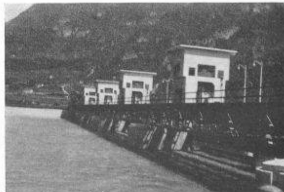
Fig. 3. — Le barrage, vue d'amont.
