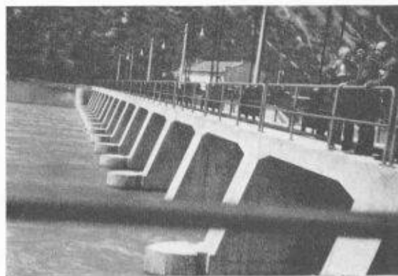
Fig. 8. — L'ouvrage de prise, vue d'aval.
