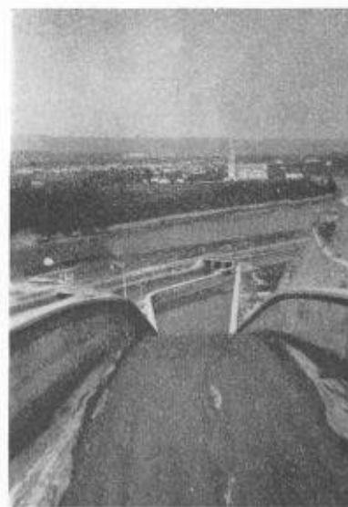
Fig. 13. — Usine de Bussolengo. Le couloir de décharge.
