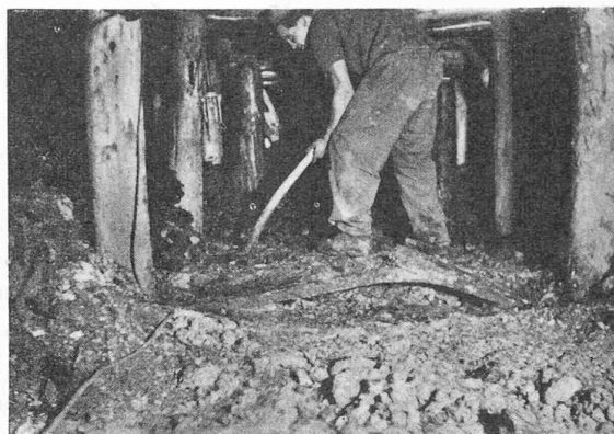
Fig. 13. — Remblayage dans la partie ouest. La charge se manifeste sérieusement : bris des chapeaux, enfoncement des jambes dans le « mur » ; rétrécissement de la galerie par poussée latérale, gonflement du « mur » (le plateau reliant les jambes et servant de base s'est arqué) 1 .
