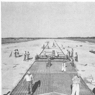
Fig. 9. — Le bétonnage de la dalle.
