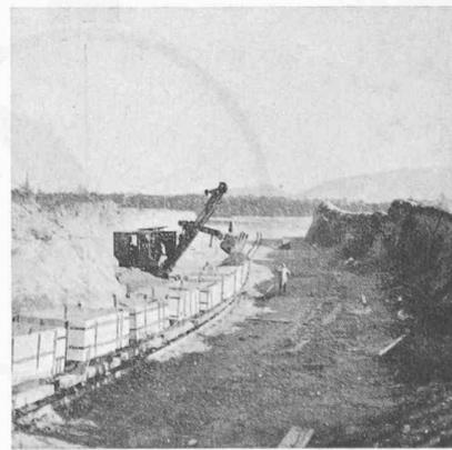
Fig. 11. — Pelle travaillant en tranchée, au Renard.
