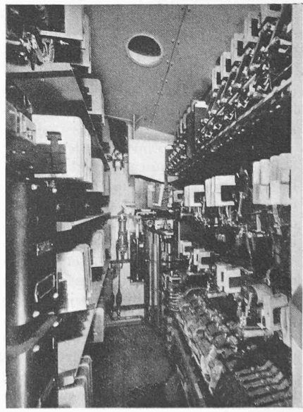
Fig. 15. Cabine des appareils des autorails.
