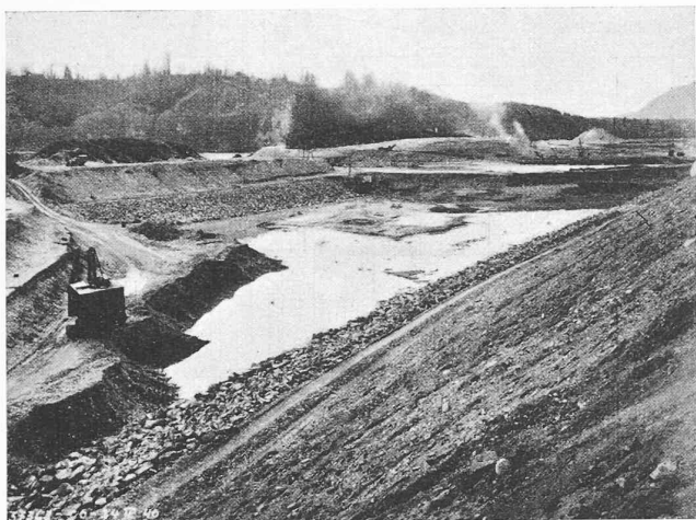
Fig. 12. — Exécution à sec des coupures des presqu'îles.
