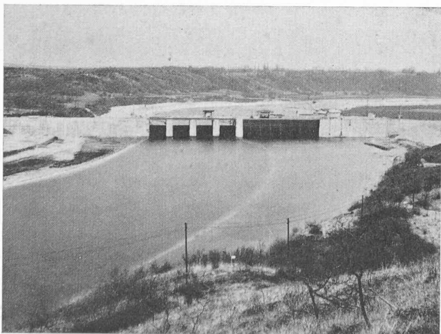
Fig. 39. — Vue générale de l'amont au début de la mise en eau. (A comparer à fig. 23 et 1.)
