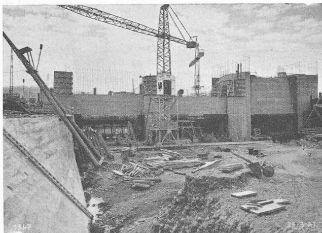
Fig. 26. — Chantier du barrage vu du mur en aile amont.
