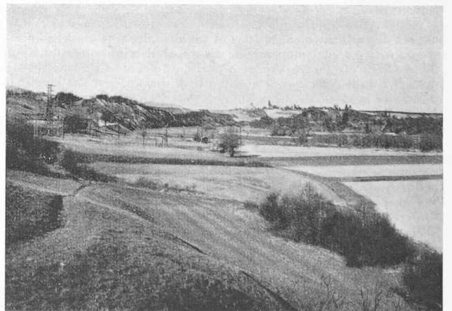
Fig. 3. — Emplacement de l'usine vu de l'aval (rive droite).
