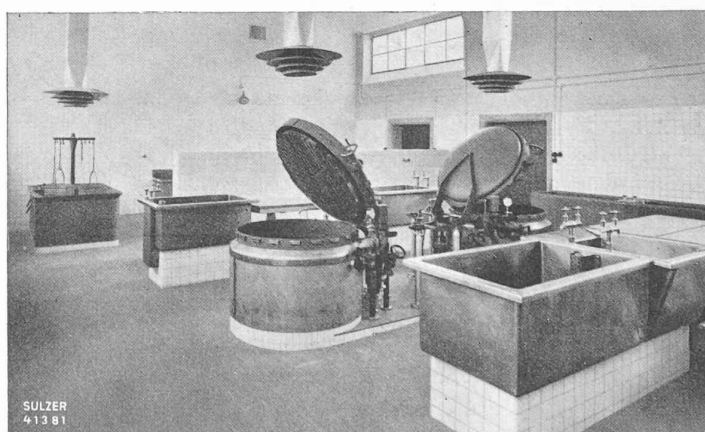
Fig. 11. — Triperie du nouvel abattoir de Winterthour. Au centre, deux chaudières Sulzer alimentées par de l'eau surchauffée, pour la cuisson des tripes, de 600 l de capacité chacune, avec appareils de fermeture hydraulique et dispositifs de sécurité automatique; au premier plan, à droite et à gauche, des bacs d'inspection de dépôt et de lavage, en acier inoxydable, fournis par la maison Sulzer Frères. La triperie contient encore un autoclave basculant de 300 l et une marmite basculante de 100 l, tous deux reliés au réseau d'eau surchauffée.
