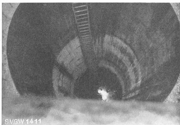
Fig. 2. — Avant-puits terminé, premier contact avec la surface de la nappe phréatique.
