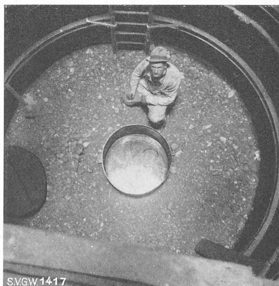
Fig. 8. — Au fond de l'avant-puits, fouçage et cuvelage terminés. Sous la surface visible, une eau limpide de 30 m. de profondeur est prête à l'exploitation.
