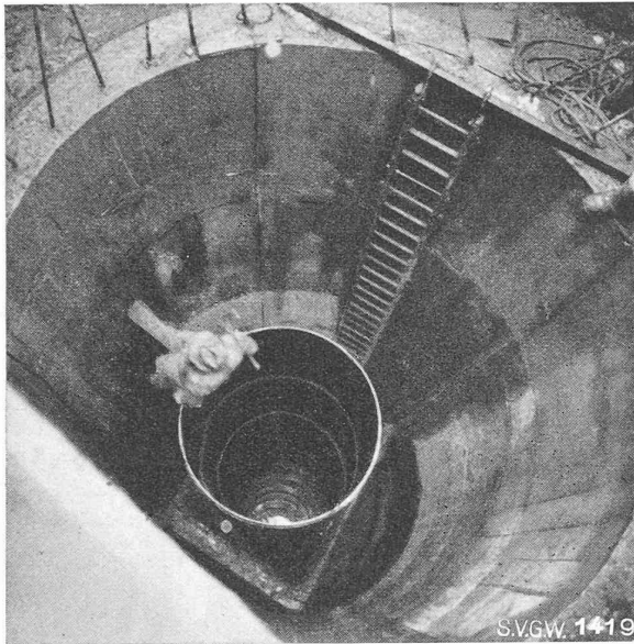
Fig. 4. — Mise en place des éléments du premier cuvelage de diam. 1500 mm.
