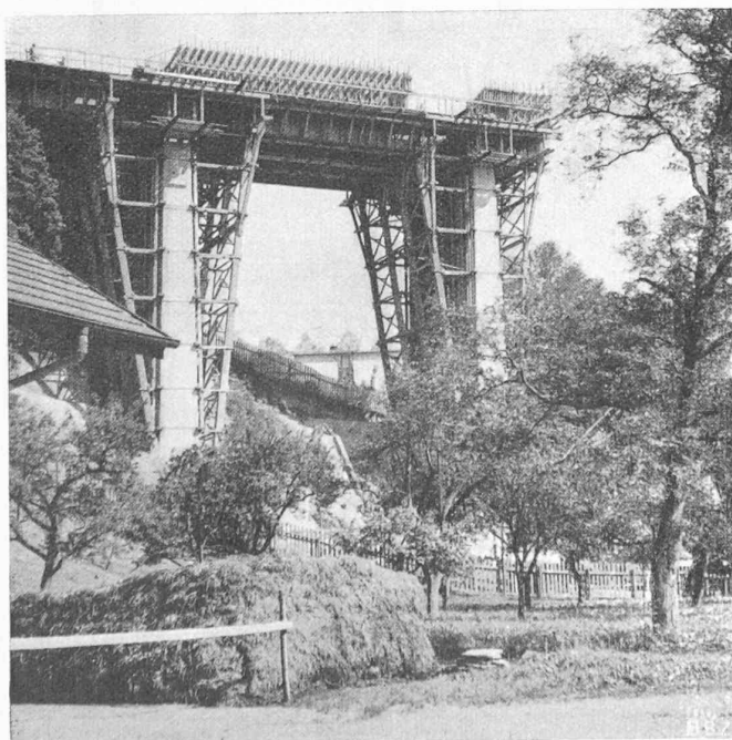
Fig. 28. — Echauffage à contre-fiches en bois et acier, lot 4 (7 juin 1938).
