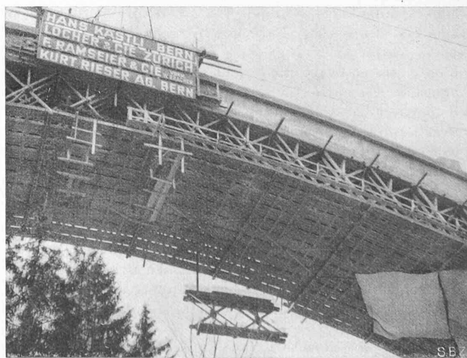
Fig. 46. — Commencement des travaux de démontage du cintre de la grande voûte (27 février 1939).
