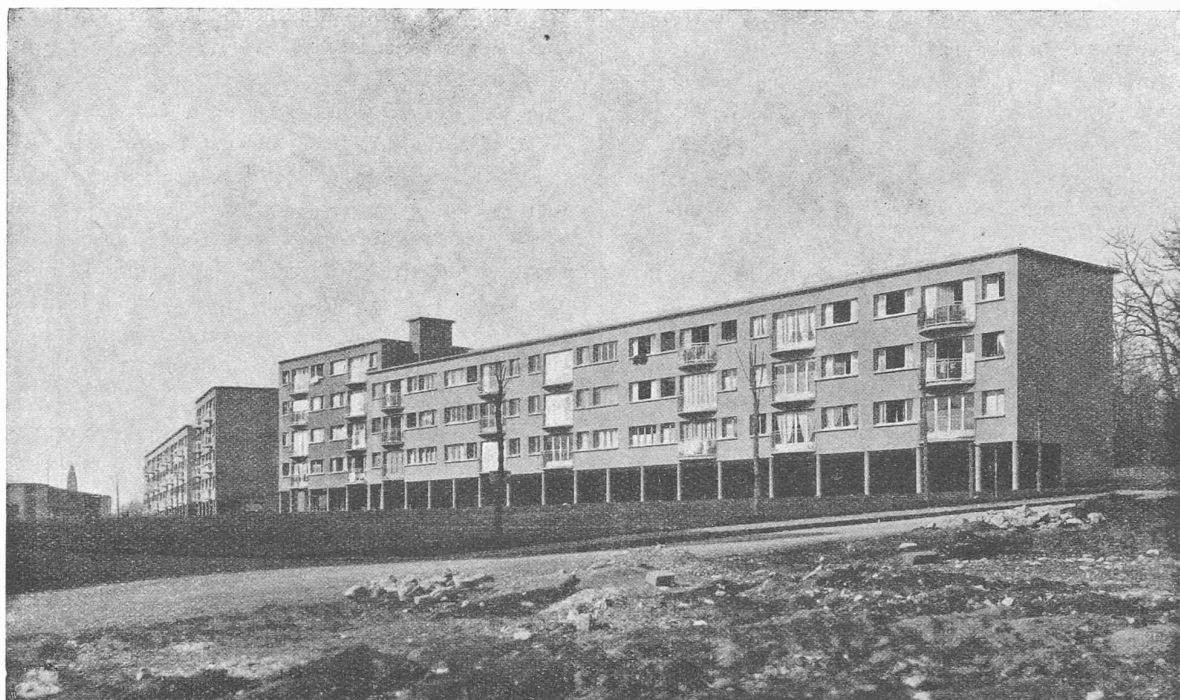
Fig. 5. — Cité Vieusseux, à Genève. Groupes C et D. Façade principale. — M. L. Vincent, architecte.
