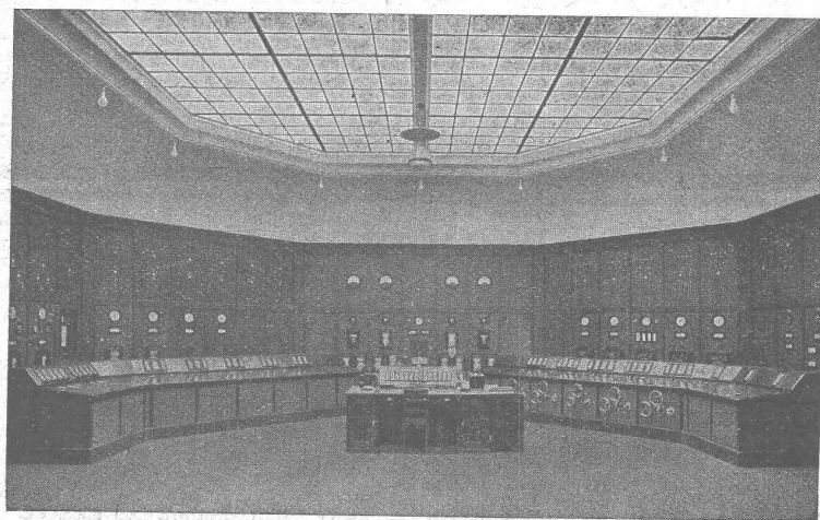
Salle de commande à l'usine électrique d'Amsteg. (Electrification des Chemins de Fer Fédéraux).
