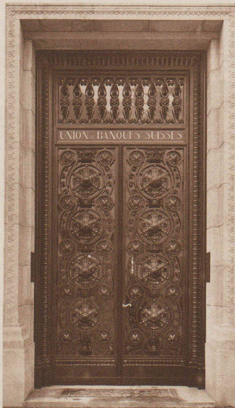
Porte d'entrée en fer forgé.
