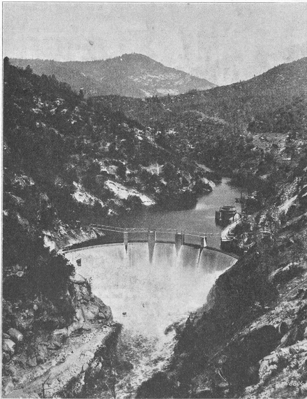
Fig. 1. — Le barrage sur le San Joaquin et la prise d'eau qui alimente l'«Electric Giant», Southern California Edison Company.
