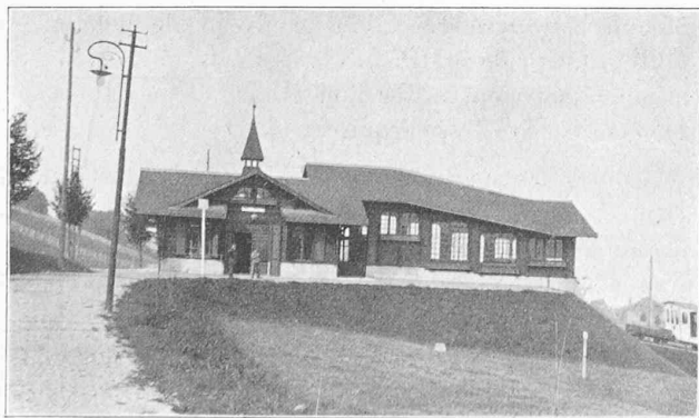
Fig. 5. — Station supérieure. (Vue du côté de la salle d'attente.)
