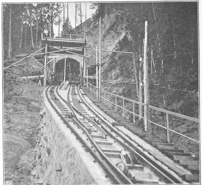
Fig. 21. — Evitement et tunnel de la 1 re section.
