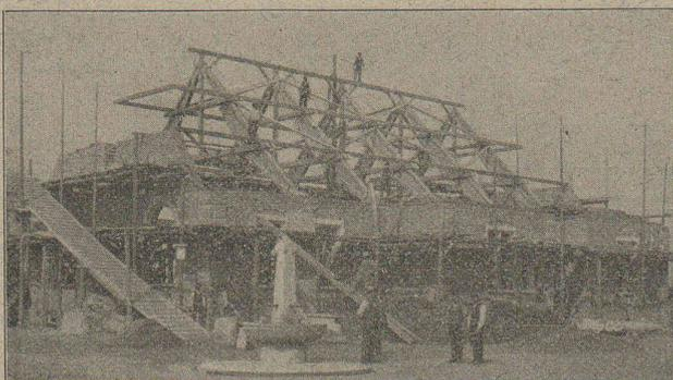
**Poutres composées** à remplissage parabolique, pour portées libres jusqu'à 8 m. et surcharges considérables.
