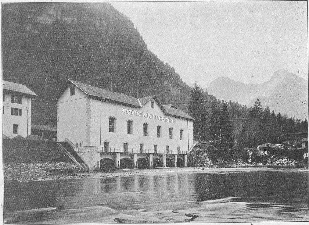
Fig. 3. — Vue générale de l'usine hydro-électrique de Montbovon, sur la Sarine.
