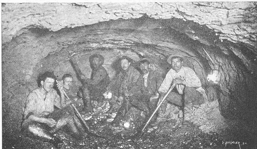
Fig. 8. — Le fond du tunnel au moment du marinage.
