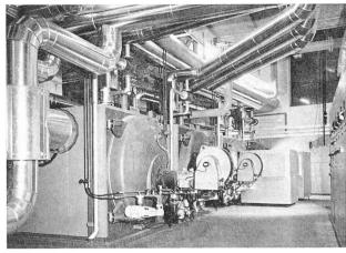
Fig. 4. — Répartition de la puissance sur plusieurs unités : ici, quatre chaudières de 2,5 Gcal/h, brûleurs mixtes gaz/mazout modulants (chaufferie de l'immeuble administratif de Nestlé, à Vevey).
