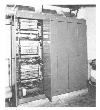
Fig. 5. — Batterie de générateurs muraux, puissance totale 315 000 kcal/h.
