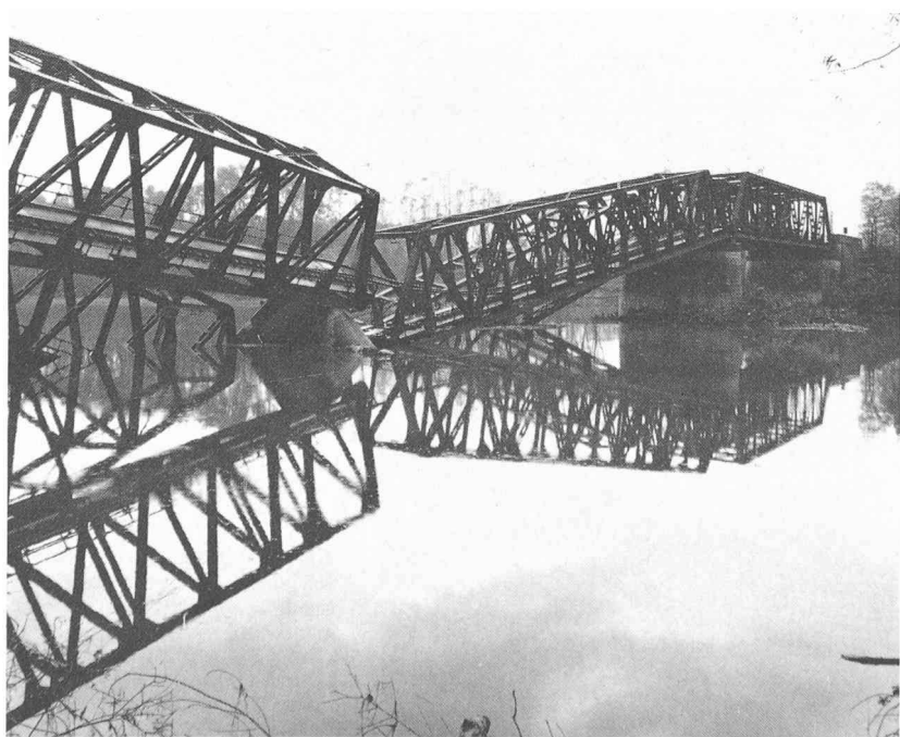
Le pont sur la Toce, près de la gare de Verbania. On distingue la pile qui a basculé, minée par les eaux en crue.
