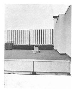
Fig. 4. — Un des trois évaporateurs air/eau sur le toit de la maison. (Photo: Stadtwerke Dortmund.)
