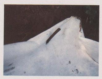
Le non-tissé est en place. Afin d'éviter une perte latérale de toutvenant, la nappe est « agrafée » latéralement à l'aide d'« aiguilles » métalliques (6 mm) ou de piquets. Afin de permettre la réalisation correcte du barrage anticontaminant, la largeur de laize choisie fut de 4,20 m pour une largeur de profil de 3,0 m (0,60 m + 3,00 m + 0,60 m).
