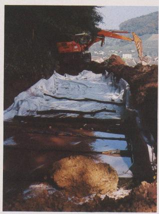
Comparé aux autres fibres utilisées pour la fabrication de nontissé, les filaments de polypropylène présentent le plus grand allongement (env. 80 %). Il se comporte de ce fait le mieux face aux énormes efforts de poinçonnement rencontrés lors de la mise en place de la couche de fondation (traction/allongement). La pose latérale de rondins sur la nappe, indispensable dans de très mauvais sols, contribue à augmenter la stabilité de l'ensemble.
