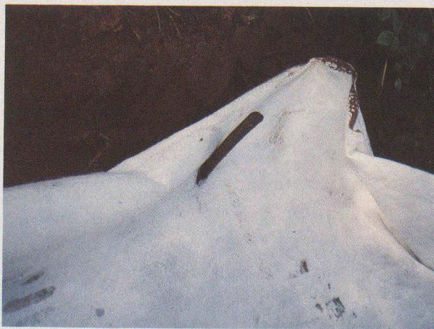
Le non-tissé est en place. Afin d'éviter une perte latérale de tout-venant, la nappe est « agrafée » latéralement à l'aide d'« aiguilles » métalliques (6 mm) ou de piquets. Afin de permettre la réalisation correcte du barrage anticontaminant, la largeur de laize choisie fut de 4,20 m pour une largeur de profil de 3,0 m (0,60 m + 3,00 m + 0,60 m).
