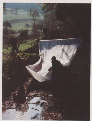
La bobine est tenue au-dessus du sol par l'intermédiaire d'un simple dispositif de déroulement. Cette méthode présente l'avantage de permettre une mise en place rapide et précise de la nappe.
