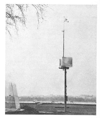
Fig. 3. — Capteur de vent NEZ. A gauche, les vitres protégeant les bassins.
