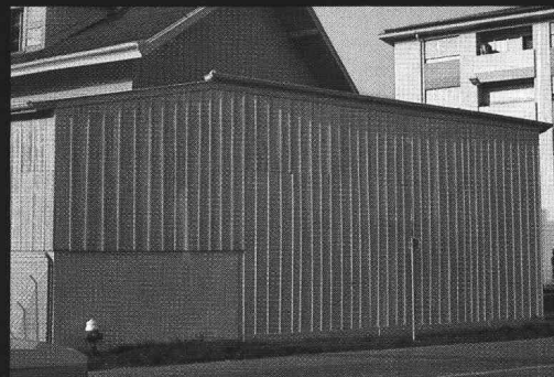
Réfection d'un hangar en bois à Bussigny
