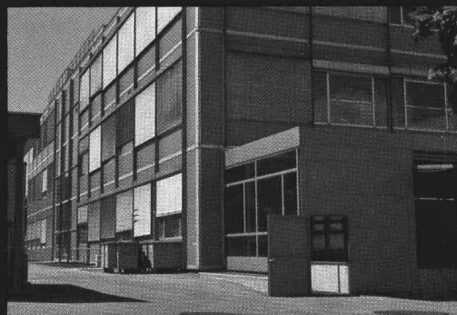
Immeuble Kodak à Renens
