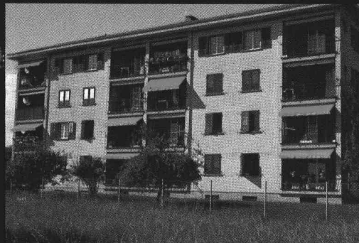
Volets d'immeubles locatifs à Bussigny
