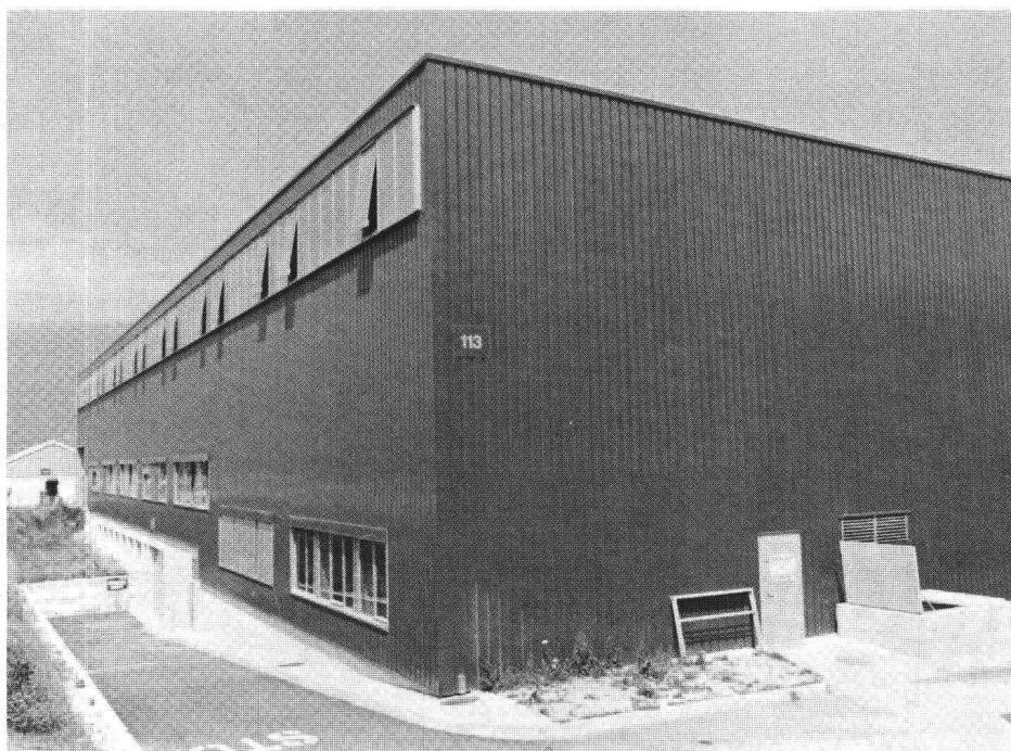
Revêtements de façade et supports de toiture en acier nervuré ACIÉROID de halles au CERN (Centre européen de recherche nucléaire) près de Genève — plus de 35 000 m<sup>2</sup>.
