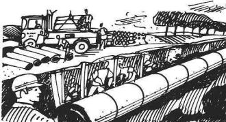
L'incorporation de bandes d'étanchéité par une main-d'oeuvre spécialisée, et ceci dans des conditions ambiantes optimales, permet une mise en oeuvre rationalisée des tuyaux sur les chantiers.
