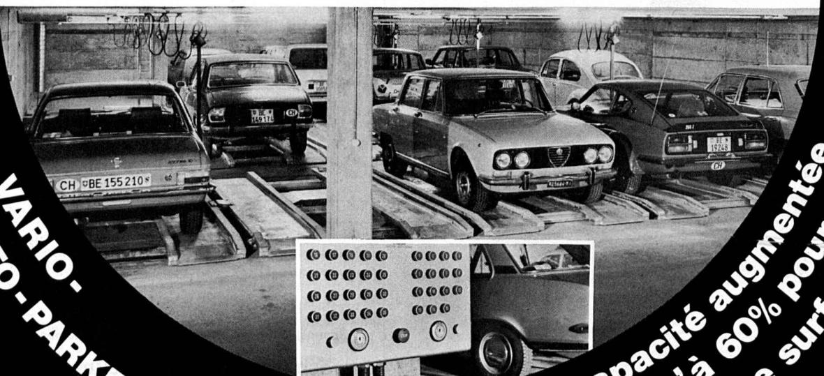
VARIO-AUTOPARKER, le système de parking compact, a fait ses preuves depuis des années dans des garages d'immeubles commerciaux et d'habitation en Suisse et à l'étranger. Sa construction est simple et par conséquent avantageuse. Voici les avantages principaux du système par rapport au parking traditionnel : jusqu'à 30 % de réduction du coût, 60 % de stationnements en plus sur les mêmes surfaces.
